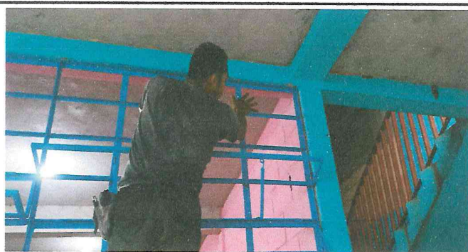
Foto 5: Instalación de vidrios en ventanales.
