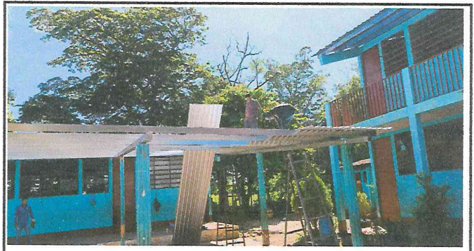
Foto 4: Cambio de laminas.
