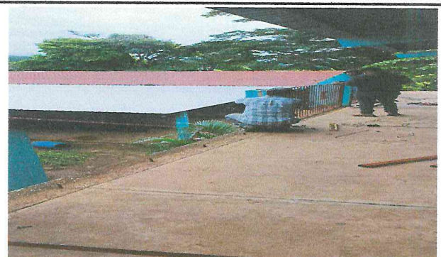
Foto 2: Instalación de Barandales.
