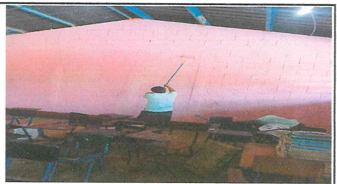
Foto 4: Pintura en salones.
