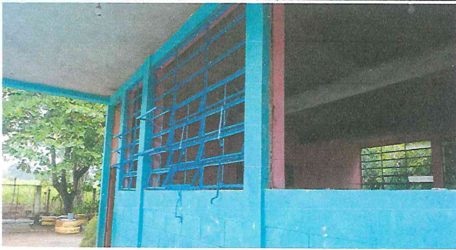
Foto 1: Desmontaje y mantenimiento a ventanales.
