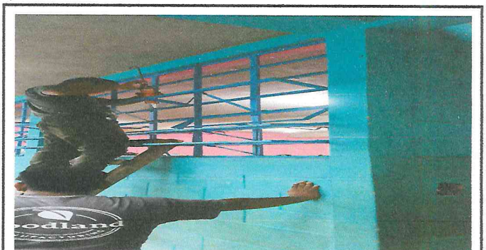
Foto 6: Instalación de vidrios en ventanales.
