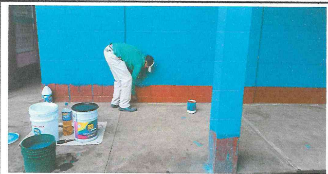
Foto 3: Pintura en salones.
