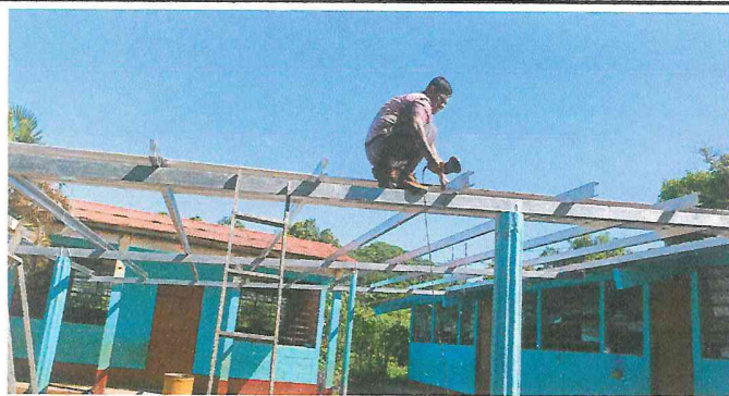
Foto 3: Cambio de estructura metálica.
